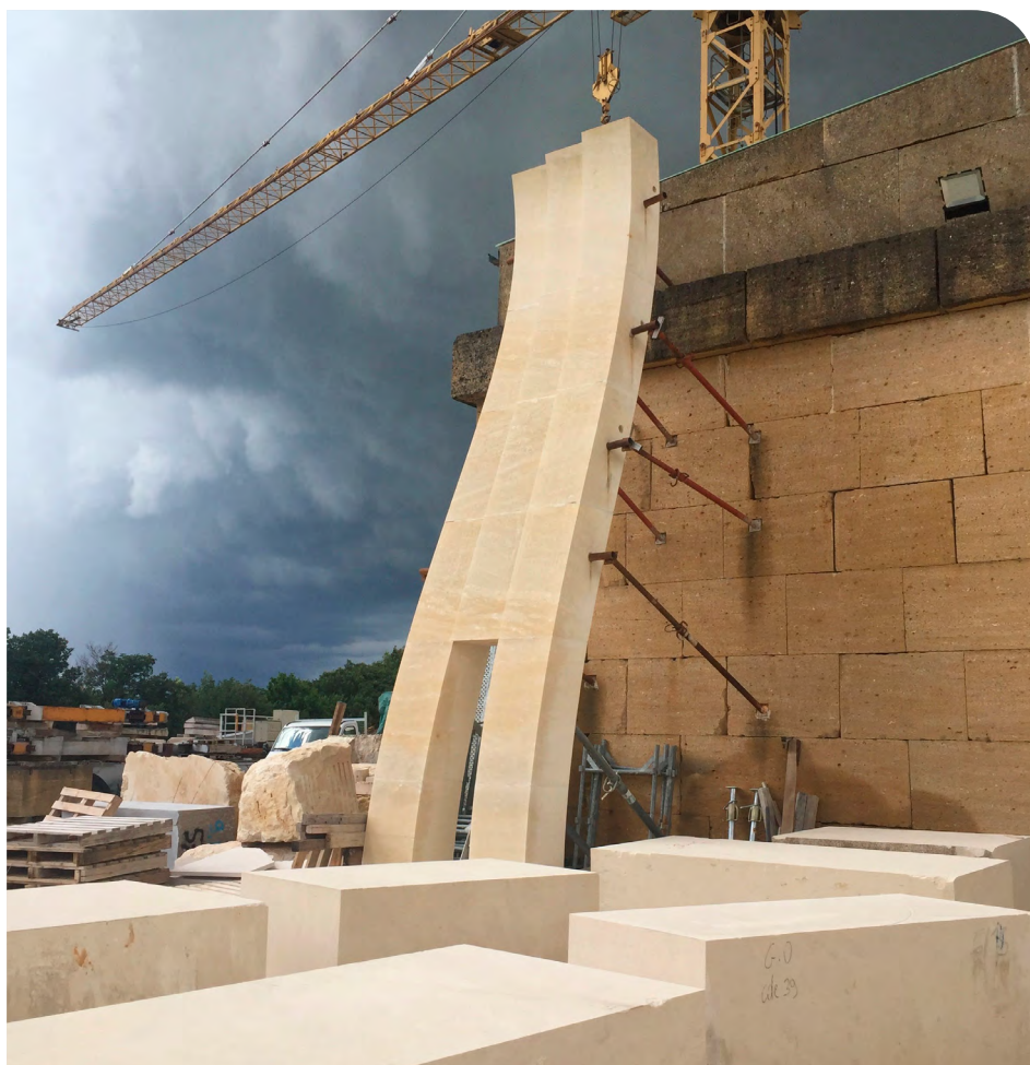
Pose du mur ondulant du caveau de la Maison Delas Frères – Photo : CFSA
