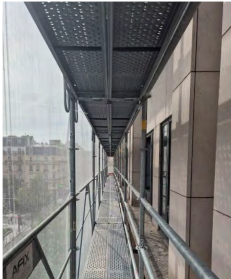
Photo : Réhabilitation de l'immeuble de bureaux situé au 77 rue Anatole France à Levallois-Perret, menée par Osae Partners en tant que MO avec l'appui de Nexity en tant que MOD.
