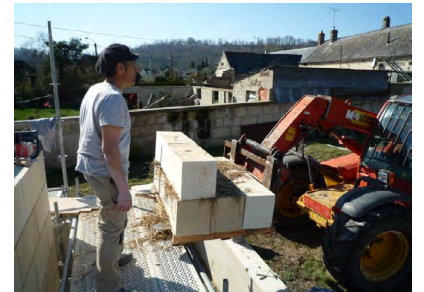
Photo : Carrières de Noyant
