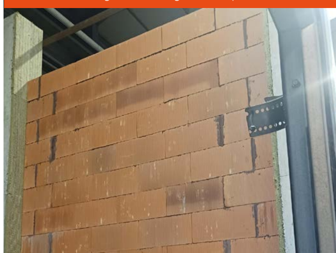
Mur avant coulage des chaînages et sans protection
