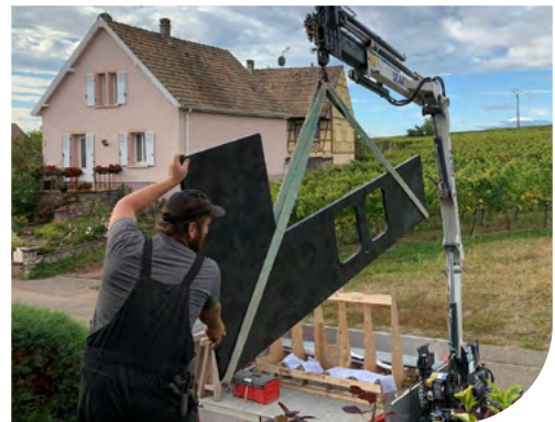
Manutention à l'aide d'une grue
