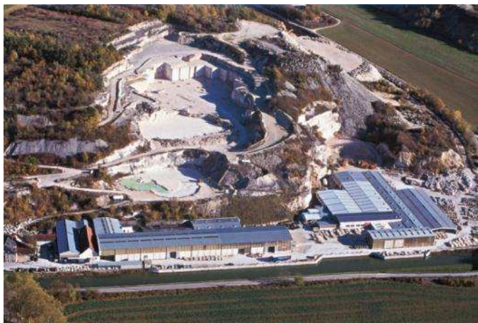
Site industriel de Ravières (89)
