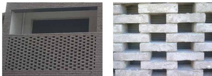
Figure 1 - Exemples de maçonneries ajourées dites moucharabiehs
