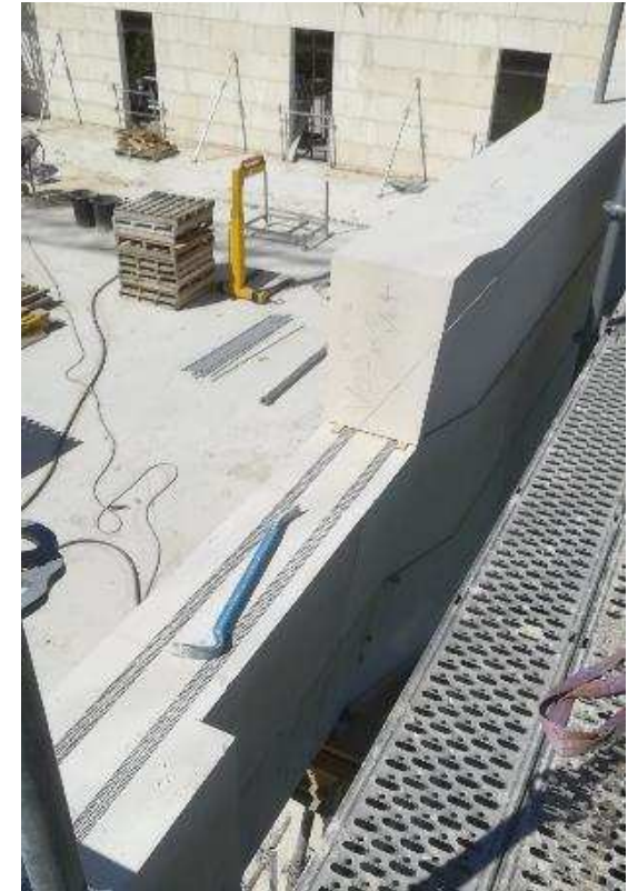
Éléments en Tervoux avec armatures horizontales Murfor
