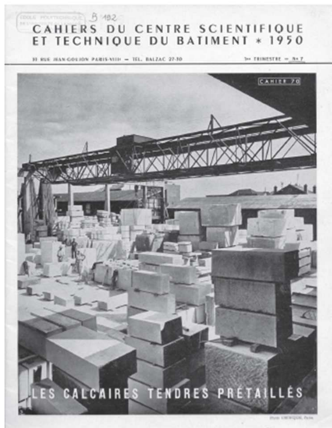
e-cahier CSTB n° 7 1950 Usine de Chauvigny ROCAMAT
