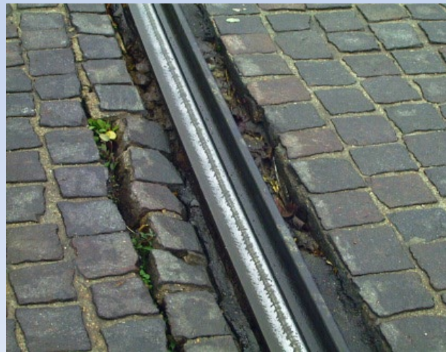
Les dégradations des voies Tramways
