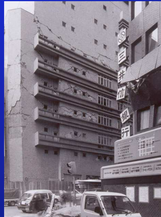
Mur armé, faibles dommages séisme de Kobé, Japon 1995
