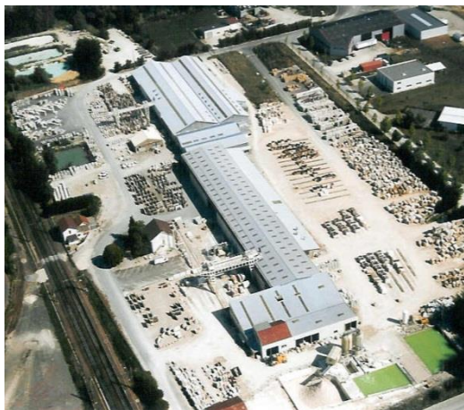
Site industriel de Corgoloin (21)
