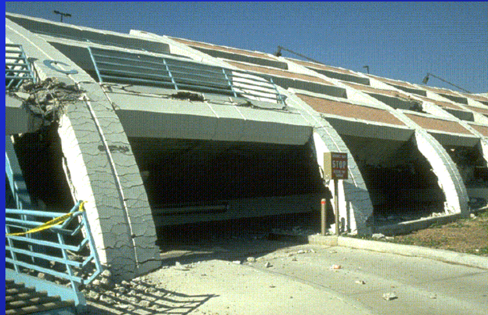
Comportement ductile. L'effondrement est dû à une erreur d'architecture et non d'exécution (effet de poteau court à l'intérieur du bâtiment), Northridge, Californie 1994
