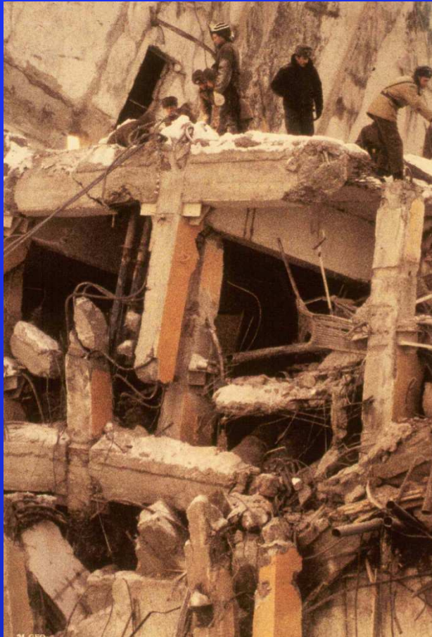
Rupture fragile (instantanée) séisme de Spitak, Arménie 1988
