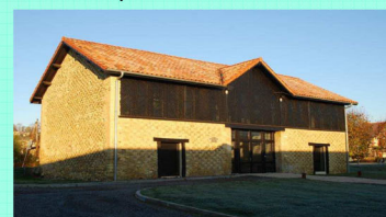
Dépendance en terre crue rénovée en cabinet de Kinésithérapeutes, Castelnaud-Magnoac (65)
