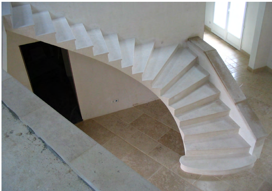
Escalier sur voûte sarrasine Photo : ISRFMP - Les Compagnons du Devoir
