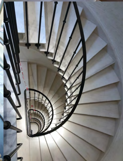
Escalier hélicoïdal à jour central Photo : Fox Marble Consulting
