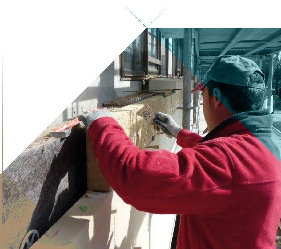
Figure 7 - Réalisation d'un mur double maçonné (épaisseur > 80 mm)
