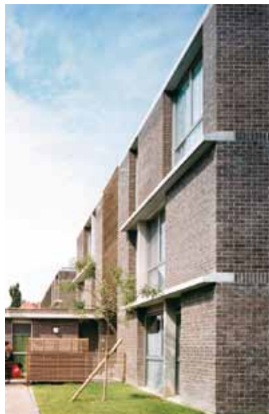
↓ Résidence de la Latte à Tourcoing.
