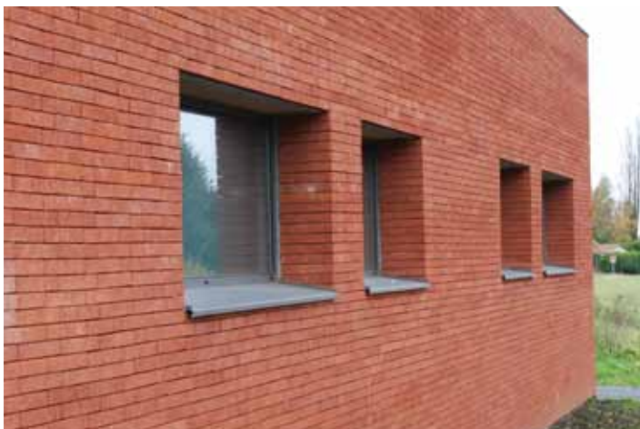
↓ Façade latérale. La pose à joints vifs donne au bâtiment une présence monolithique.
