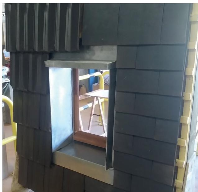
Maquette de tuiles de terre cuite posées en bardage : entourage de baie
