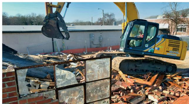
Tri des matériaux de construction sur un chantier de démolition
