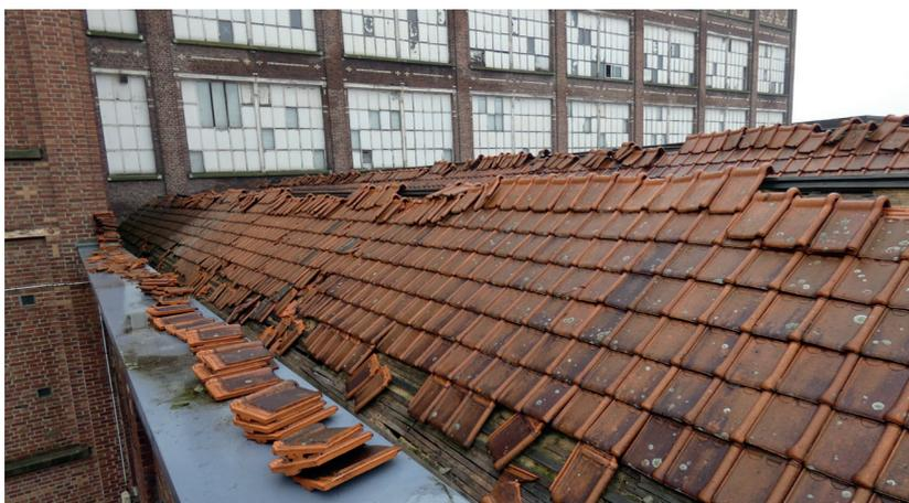
Dépose des tuiles pour le réemploi
