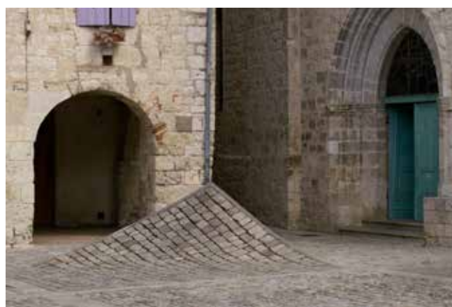
Exemple d'une réalisation de voirie innovante
