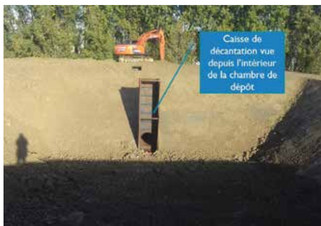
Vue de la chambre de dépôt mise en construction pour le projet « SEDIBRIC » © GPMH
