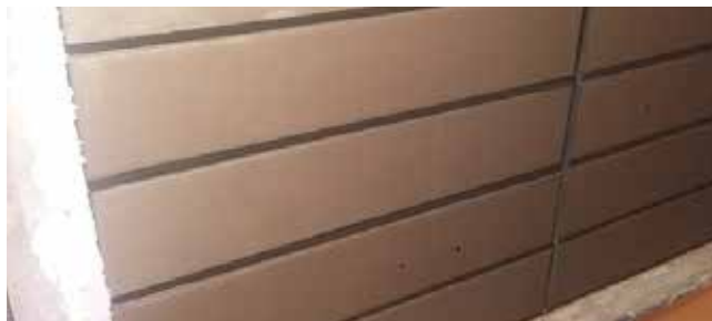
Essai selon prNF EN 772-22 : Aucune dégradation
