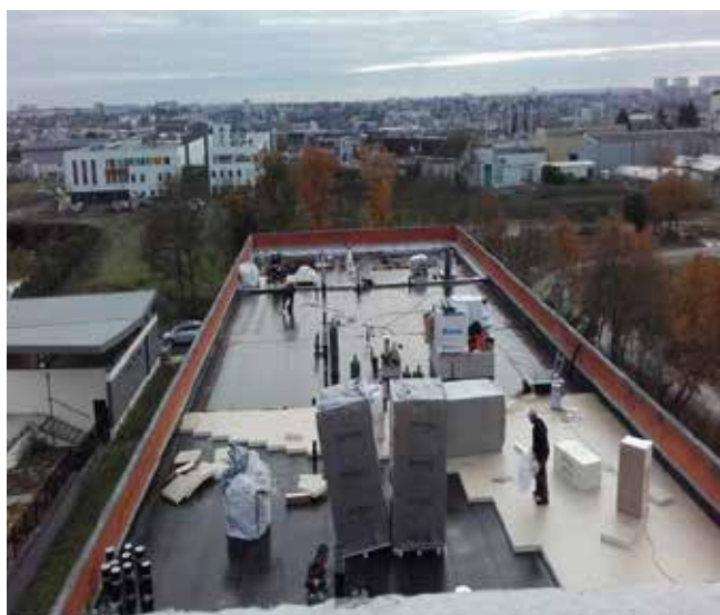
Photo n° 1 : Acrotère haut en briques à bancher de terre cuite
