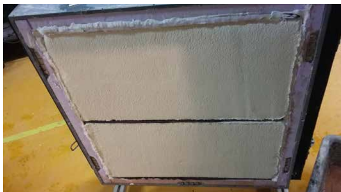
Sur briques P revêtues d'un enduit de type CS III W2
