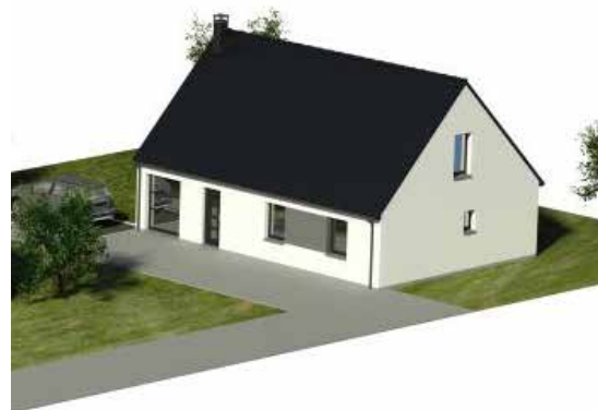
Construction en terre cuite labellisée E+C-
