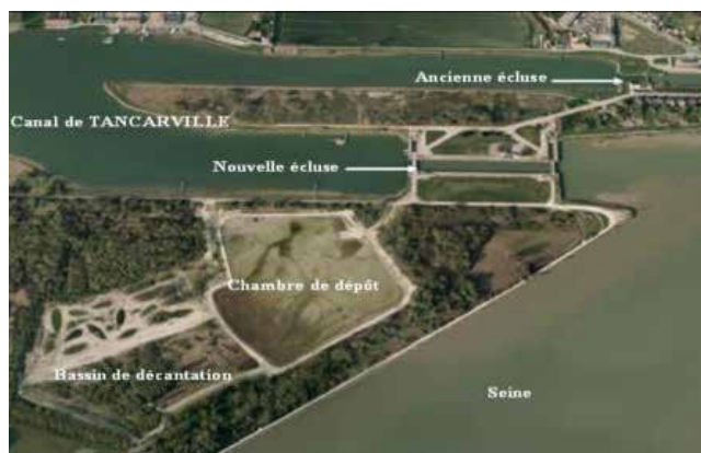
Vue de la chambre de dépôt d'argile de Tancarville © GPMH
