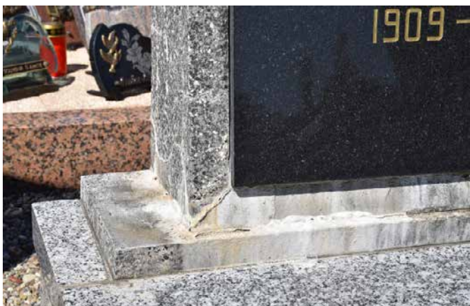
Efflorescences sur monument en granit
