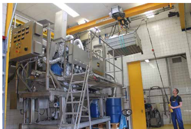
Essai pilote sur sécheur à palette chez Andritz Gouda
