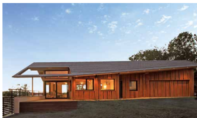
Toiture à faible pente
