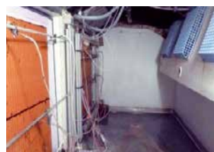
Briques nues et rampes d'arrosage (intérieur du banc)
