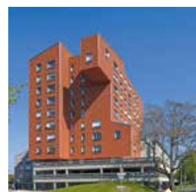
Bâtiment de 60 logements sociaux recouvert de tuiles à emboîtement en bardage (Agence Edouard François)
