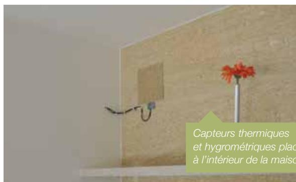
Capteurs thermiques et hygrométriques placés à l'intérieur de la maison
