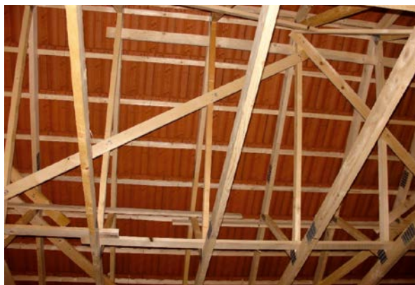
Vue de dessous de la charpente avec sa couverture (Projet SISBAT - source CEA)
