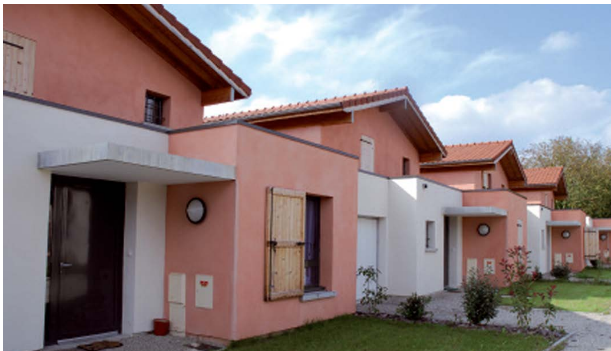
Parois réalisées en briques Monomur qui assurent une bonne isolation à la construction
