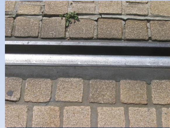
**Existe toujours ... Aucun revêtement et assemblage n'est « étanche », au mieux imperméable à l'état neuf.....**
