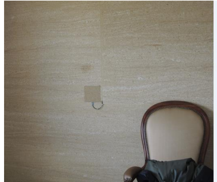
Fluxmètre sur mur intérieur
