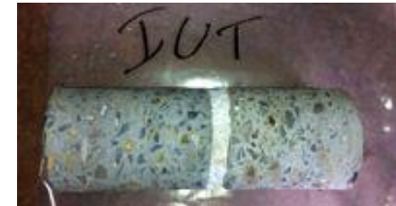
Exemple de carottage
