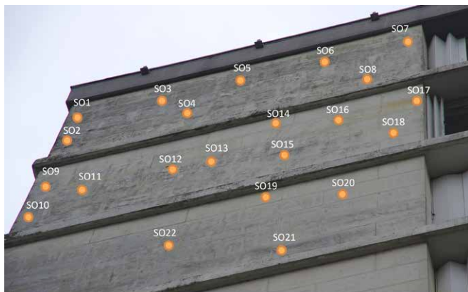
Figure 1 - Exemple d'échantillonnage sur un bâtiment collectif d'habitation
