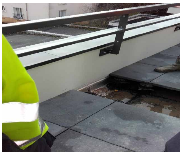
Acrotère bas en briques à bancher avec finition et garde-corps métallique
