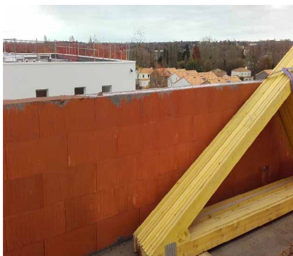
Acrotère haut en briques à bancher de terre cuite (avant enduction)
