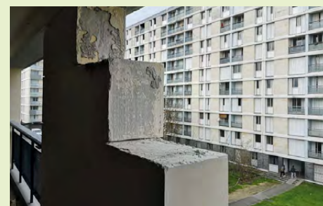
Démontage du mur calcaire pour les tests en laboratoire Photo : Bellastock.
