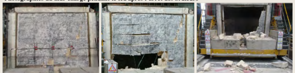
Effondrement du mur chargé pendant le feu après la ruine
