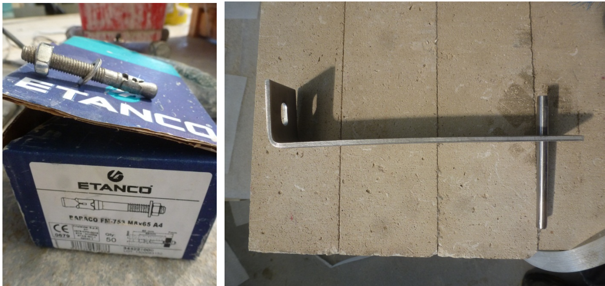
Photographies 5.3 : Vues des chevilles et des équerres à ergots
