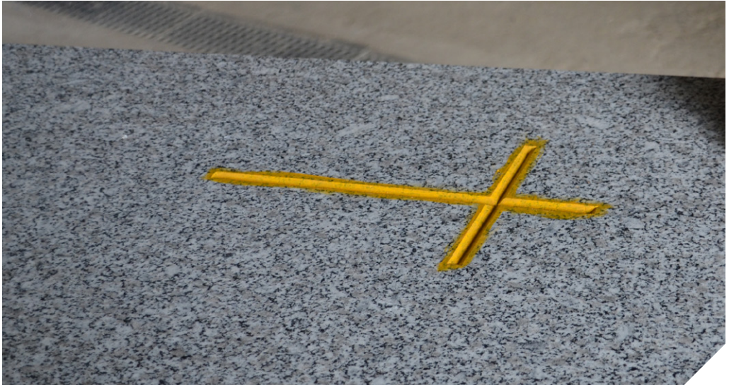
Application de la couche d'apprêt / Crédit photo : R. Maréchal
