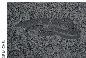
Crapaud de granit lié à une concentration importante de mica
