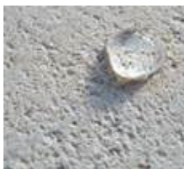
Photo n° 1 : Ex. de traitement avec un hydrofugeant de surface ; illustration de l'effet perlant.
